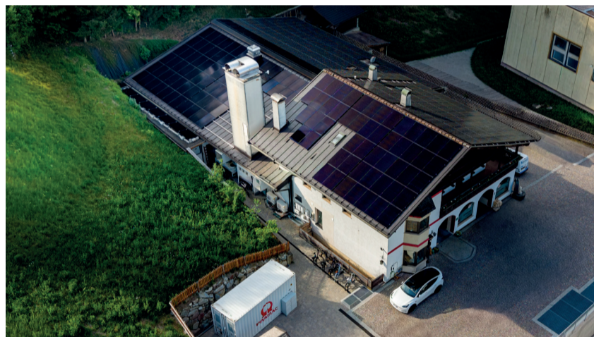
Bis zu 100 % Eigenversorgung: Die Profanter Natur-Backstube deckt heute einen Großteil ihres Strombedarfs selbst. Das System aus verteilten PV-Anlagen und Speicher, umgesetzt nach dem Modell „Autoconsumo a distanza“, amortisiert sich in wenigen Jahren.
